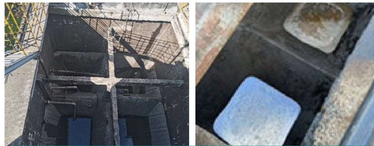
污水处理池升级改造
